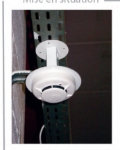
Mise en situation
