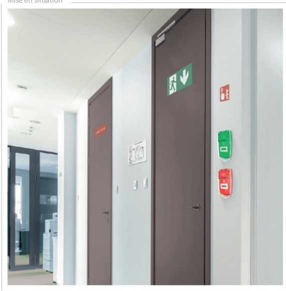
Mise en situation
